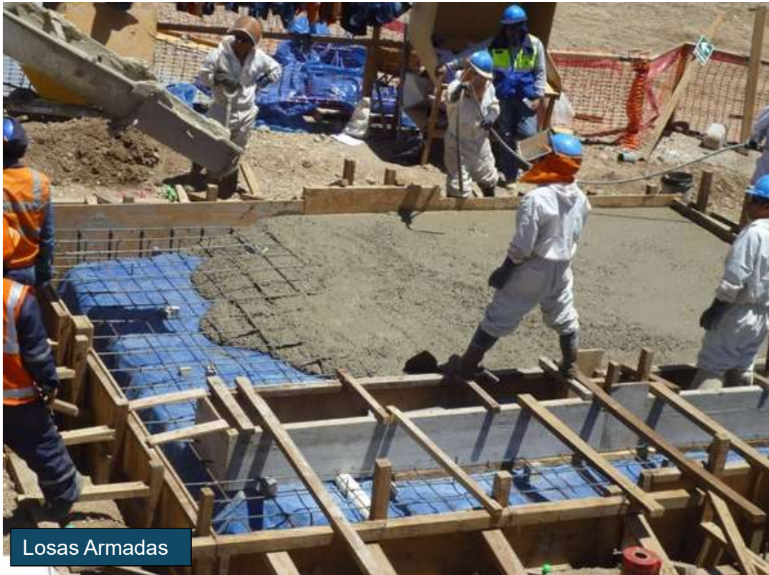
Cimentación para Edificio Metálico
